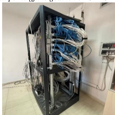
Figura nr.2 Pamjet e mëposhtme tregojnë kabllimet e rrjetit për të gjithë godinën e FSDKSH-së
