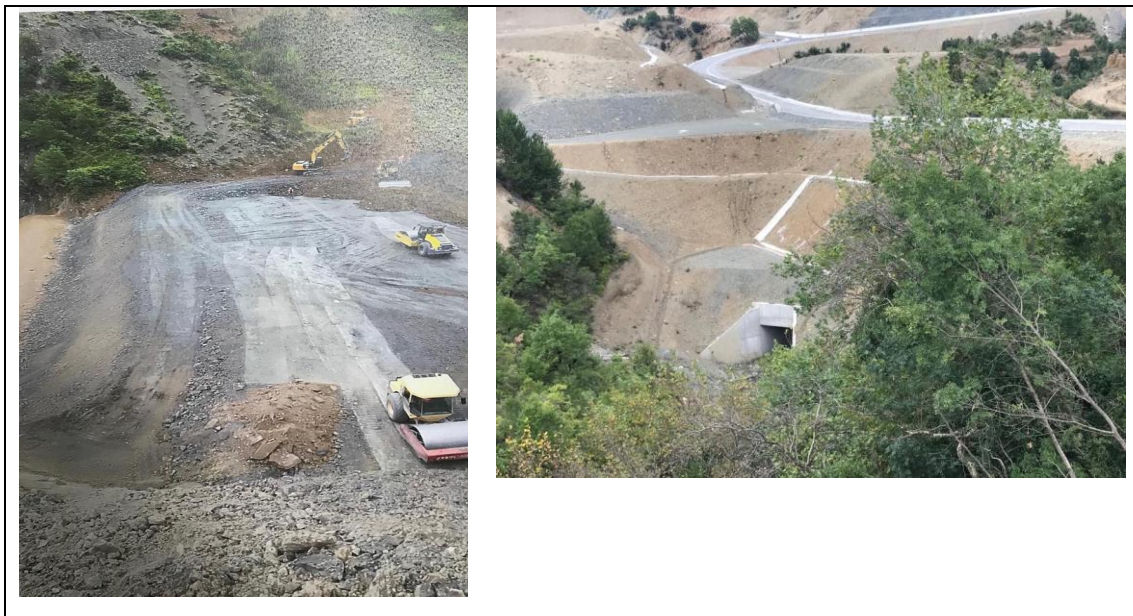
Figura 4. Mbushjet në trup të rrugës. Nga verifikimi në terren këto mbushje nuk janë realizuar në sistemin qelizor dhe janë mbushje në trup të rrugës pa masa mbrojtëse qelizore si ishte parashikuar në projektin fillestar. Ndërkohë që
