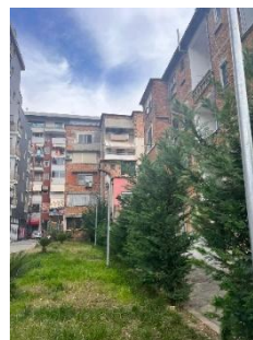
Figura 12 Blloku i Pallateve Rruga Frosina Plaku
